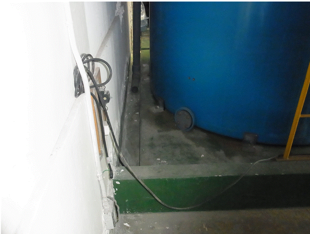
○写真 5. 小出しタンク手前の排水溝からの排水管出口
